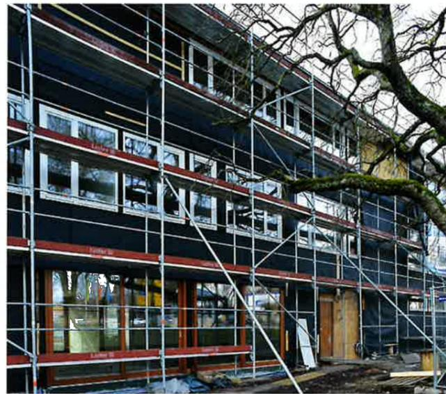
Dem Rohbau fehlt noch die abschließende Douglasien-Fassade (Fotos oben und rechts: Pfäffinger)
