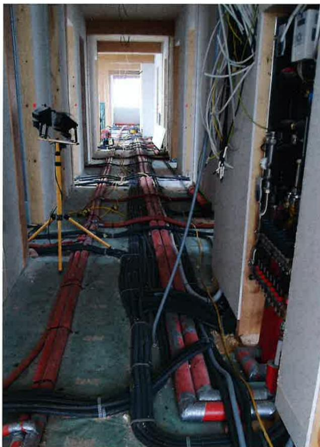
Zahlreiche Leitungen und Technikkomponenten liegen noch frei auf dem abgedeckten BSH-Boden, u. a. für die Zahnarztpraxis mit Wasseranschlüssen
