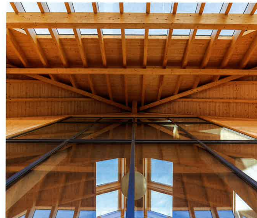
Eindrucksvolle Ansicht des offenen Dachtragwerks mit seinen großflächigen Verglasungen
