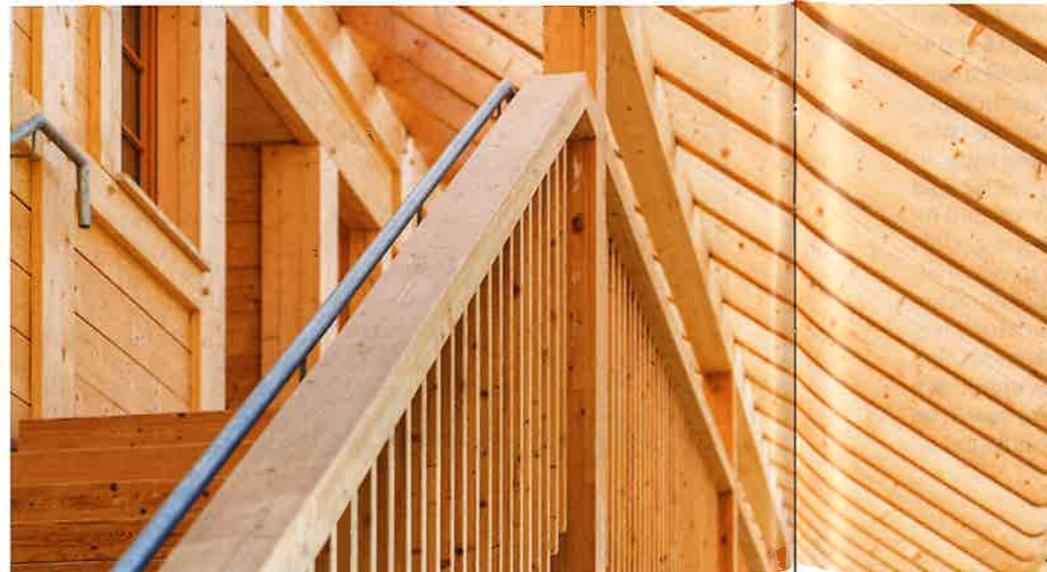
Links: Holzbau pur: Detailsicht vom Laubengang mit Außentreppe inklusive massivem Geländer, Dachüberstand und Blockbohlenfassade
