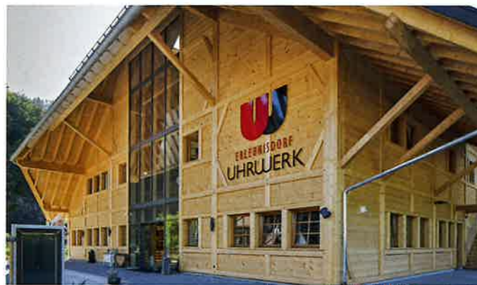
Die Blockbohlen-Fassade an der Gebäudeaußenseite weist eine Stärke von 9 cm auf
